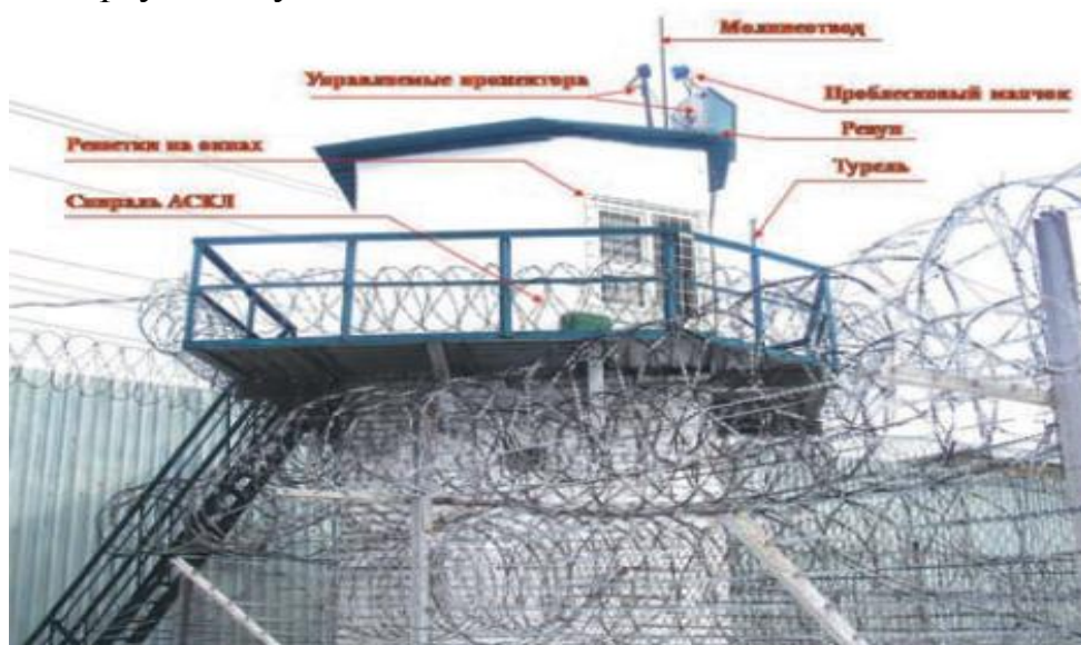
Рис. 2. Оборудование наблюдательной вышки.
